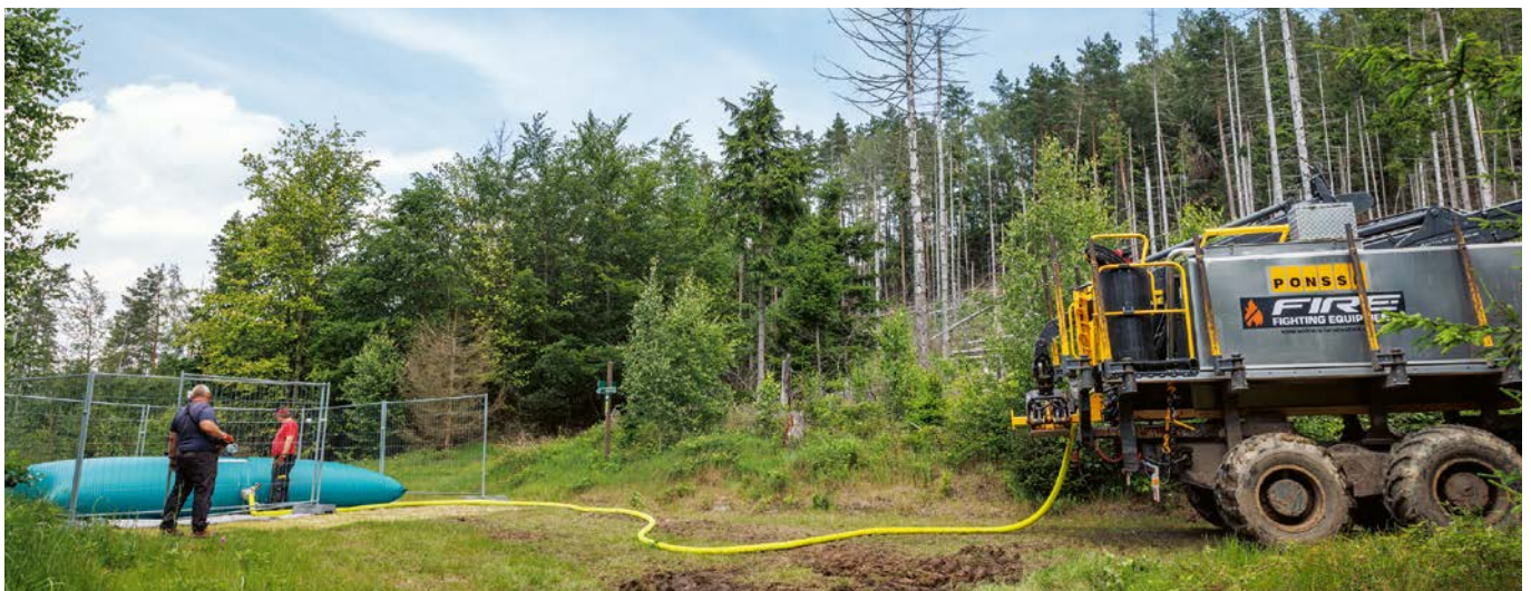
Befüllung einer mobilen Zisterne; Foto: Dr. Louis Georgi
